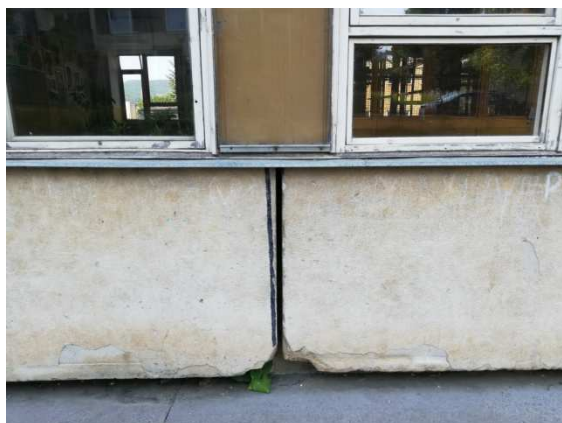
13. detail poškození rohu parapetního panelu východní fasády
