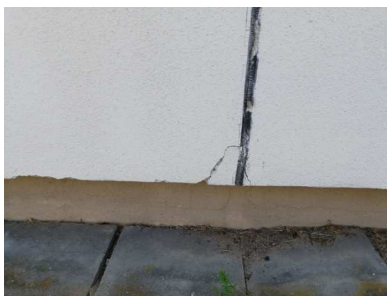
11. detail utrženého rohu západní fasády
