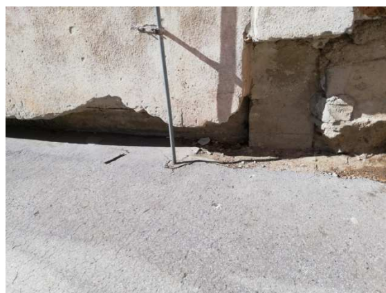
6. detail stavu soklu východní fasády v návaznosti na objekt šaten
