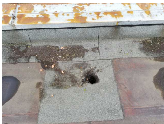
21. detail stavu atiky a střešní vpusti bez ochranného koše
