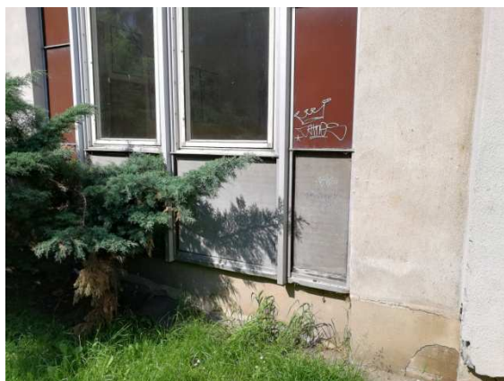
30. detail stavu lehkého obvodového pláště
