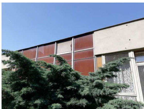
obr. 28 východní fasáda z Boletických panelů
