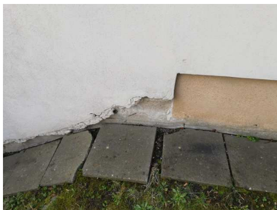
26b. okapové chodníčky a ukončení omítek nad terénem spojovacího krčku
