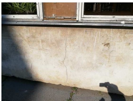
14. detail trhliny v parapetním panelu východní fasády
