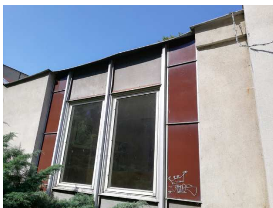
obr. 27 východní fasáda z Boletických panelů
