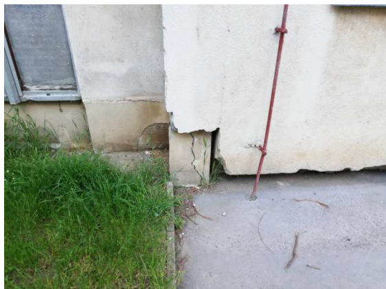
15. detail stavu parapetního panelu a příčného základového prahu jihovýchodního nároží
